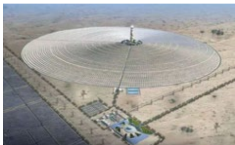
海西格尔木50MW塔式熔盐光热发电项目
